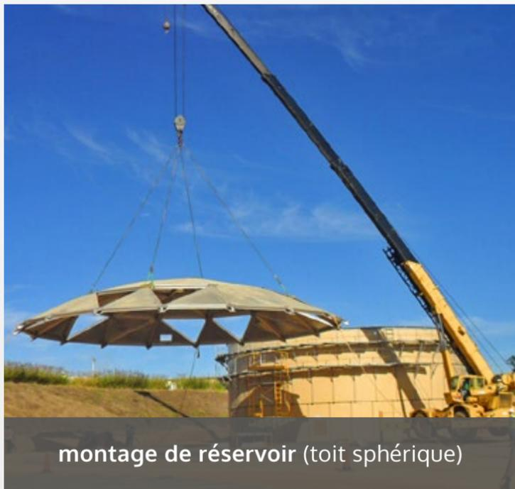
montage de réservoir (toit sphérique)
