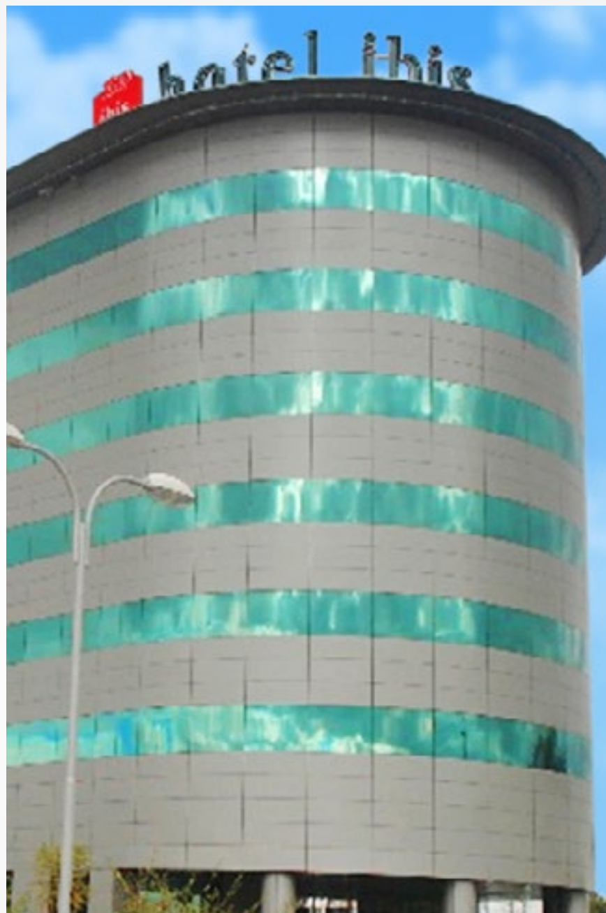
HÔTEL IBIS à Ankorondrano - façade vitrée - habillage de la façade - porte vitrée coulissante, motorisée, sur hall d'entrée - façade habillée en panneau composite
